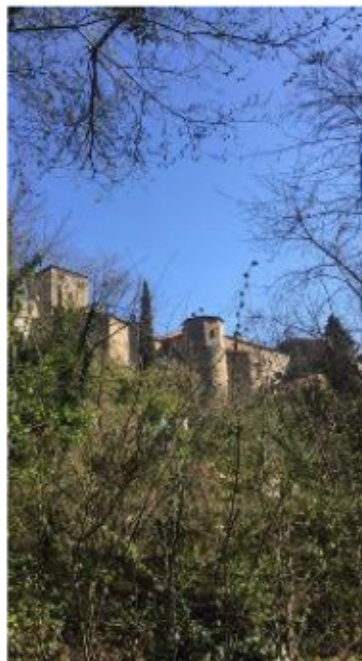
Una veduta di Portico
